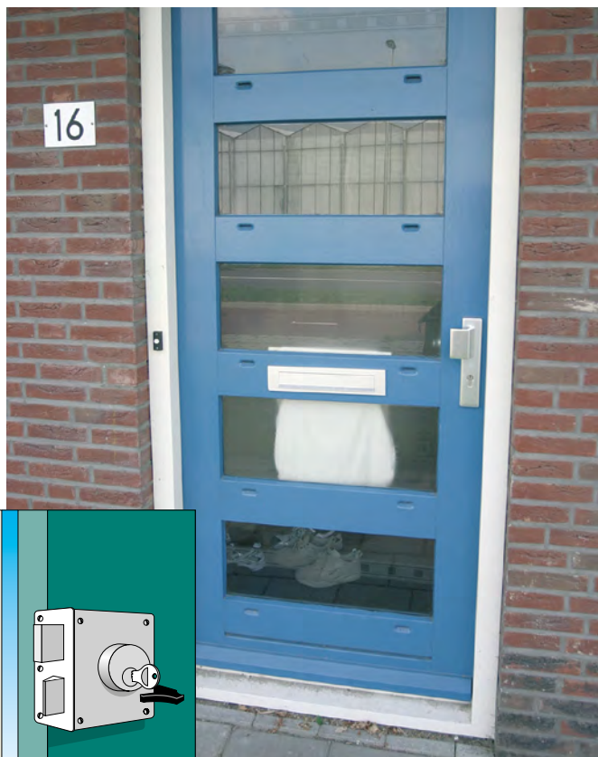
Oplegslot met cilinder en sluitkom
