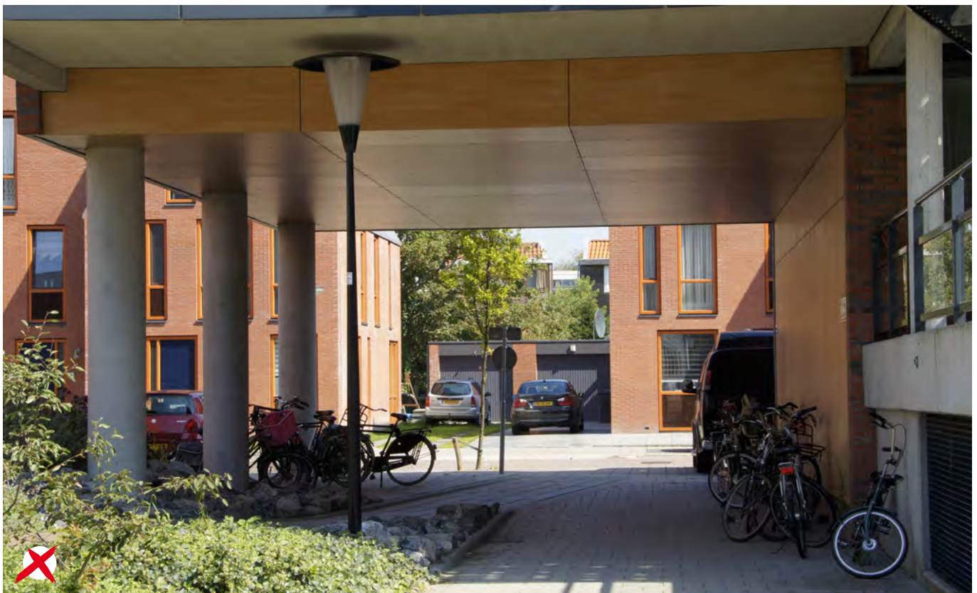
Fout: de verlichting zal niet de hele onderdoorgang kunnen verlichten, het plaatsen van fietsen is niet geregeld.
