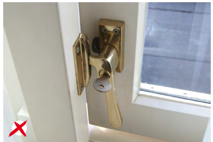
Fout: product is niet gecertificeerd en sleutel zit in het raamboompje.
