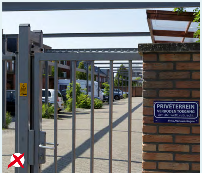
Fout: een kruk aan de binnenzijde betekent dat bewoners de deur achter zich op slot moeten draaien, en vaak doen bewoners dat niet.
