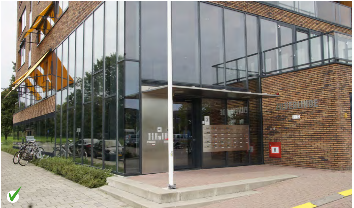
Goed: er is buitenverlichting en goed zicht.
