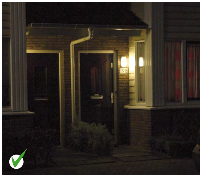
Het meest effectief is verlichtingsarmatuur aan de sluitzijde van de deur.
