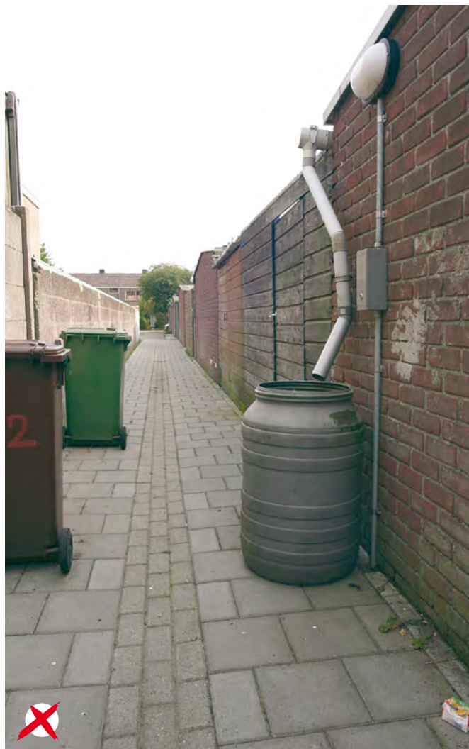
Fout: obstakels moeten worden verwijderd.
