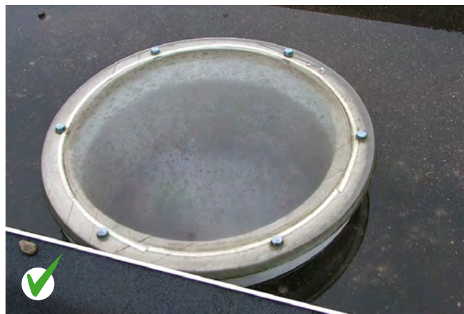
Goed wanneer lichtkoepel voldoet aan weerstandsklasse 2 van de NEN 5096.
