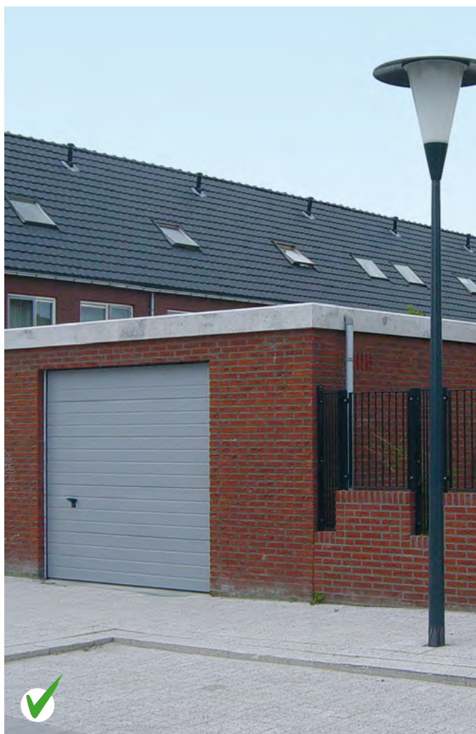
Deuren zijn drie minuten inbraakwerend en goed verlicht.
