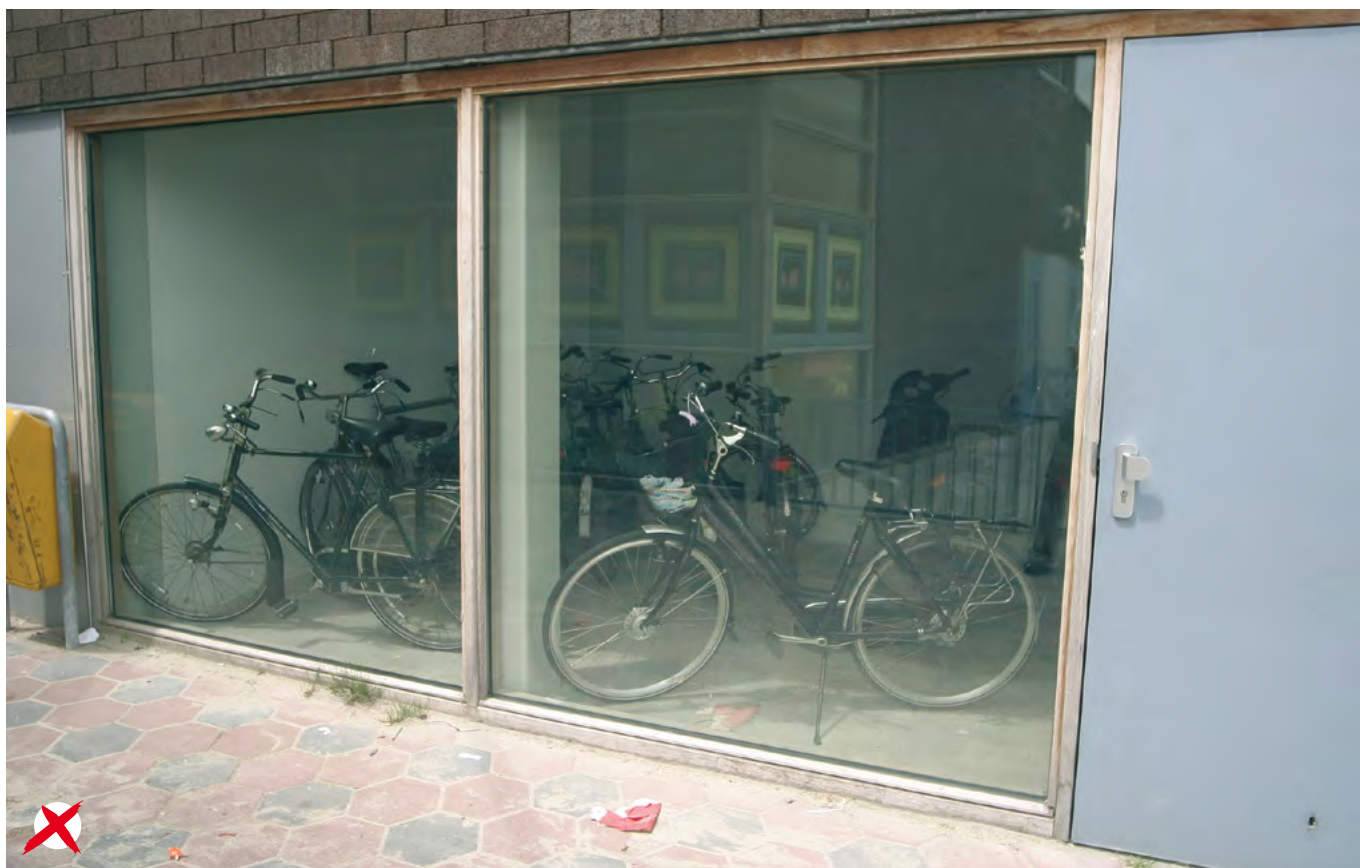
Dit is geen gewenste situatie. Let op: het glas direct naast deze toegangsdeur dient minimaal P2A te zijn en bij voorkeur is er geen zicht op de fietsen/scooters van buitenaf.
