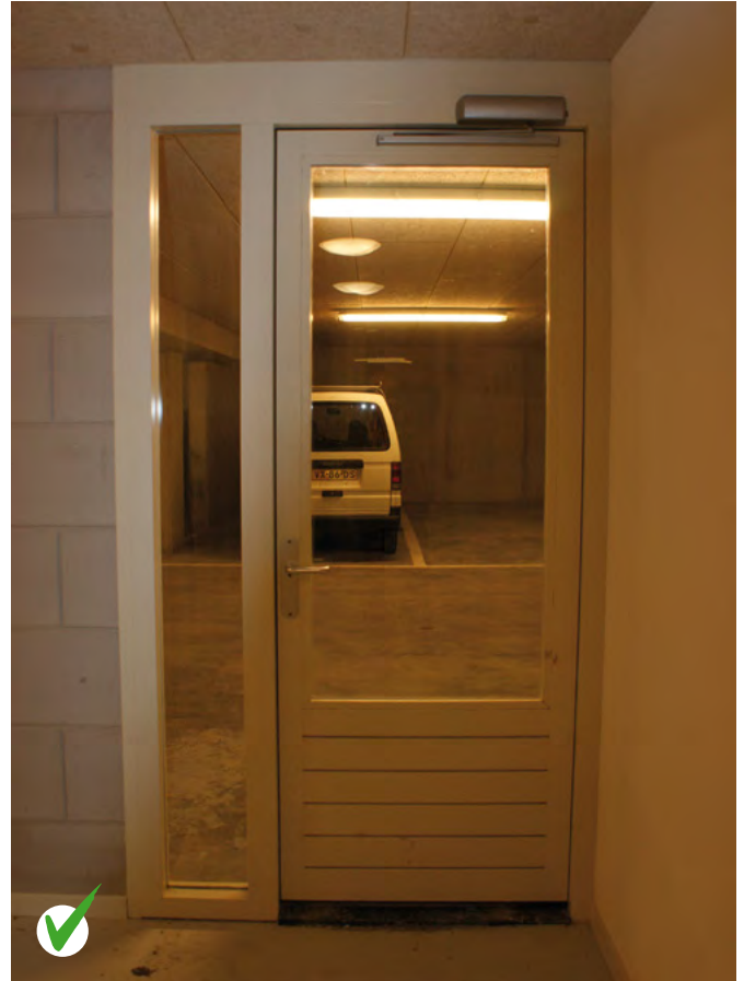
Voor het binnengaan van een garage, moet al voldoende zicht zijn op de situatie in de garage.
