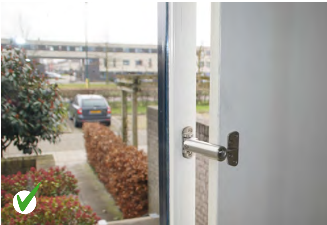
Een gecertificeerde kierstandhouder, te gebruiken bij het openen van de deur, niet als extra slot.
