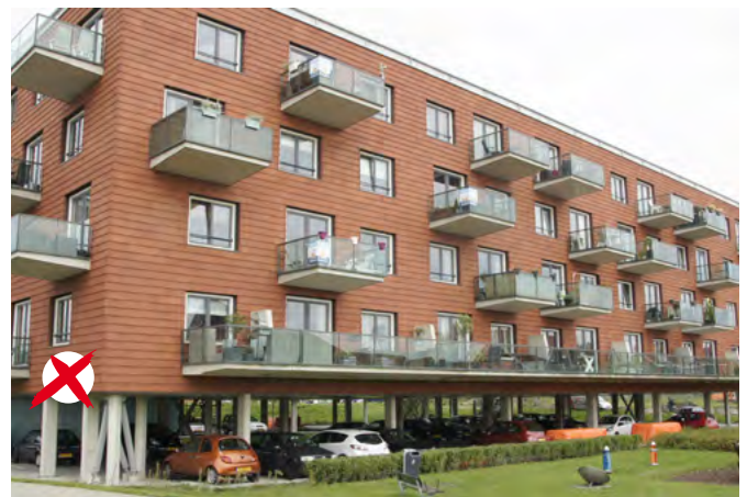
Fout: er is geen zicht vanuit de woningen op de parkeerplaatsen.
