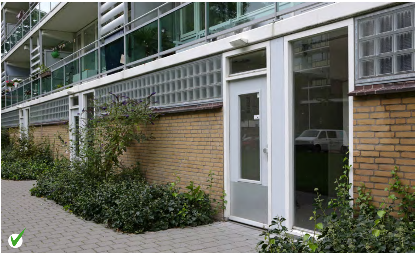
Goed: er is buitenverlichting en goed zicht.
