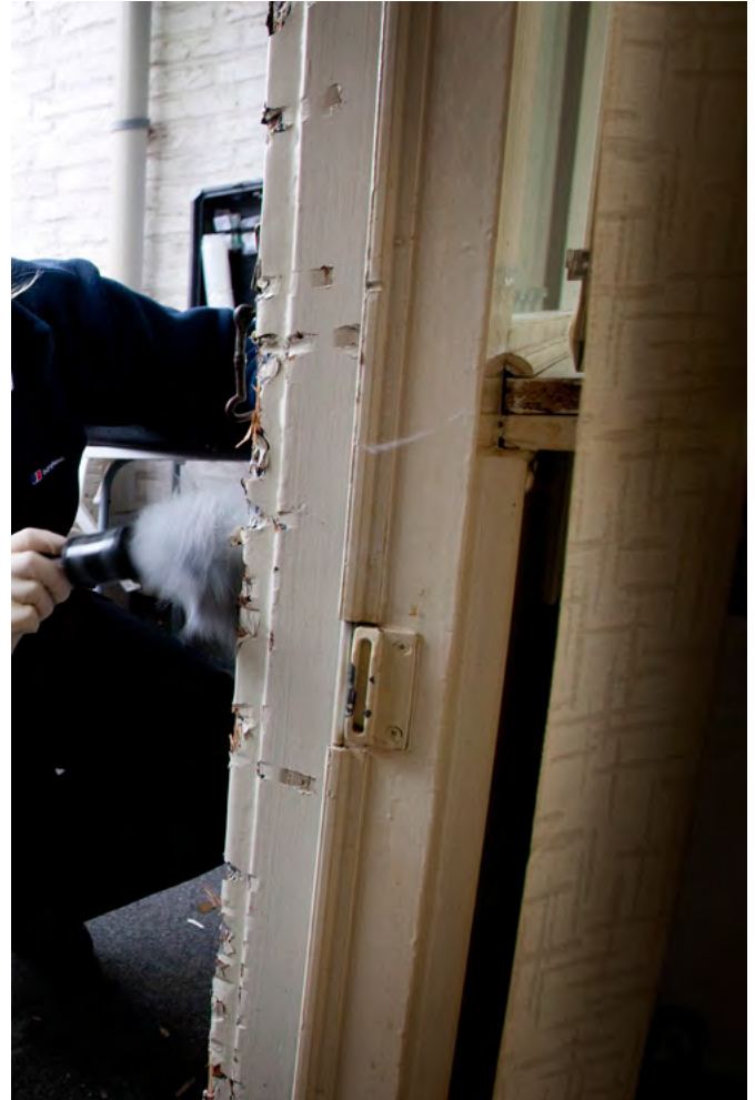
Het kozijn is dusdanig beschadigd dat het hersteld en mogelijk vervangen moet worden.
