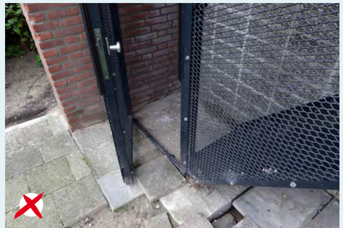
Sluiproutes ondermijnen het toegangbeheer van een wooncomplex.
