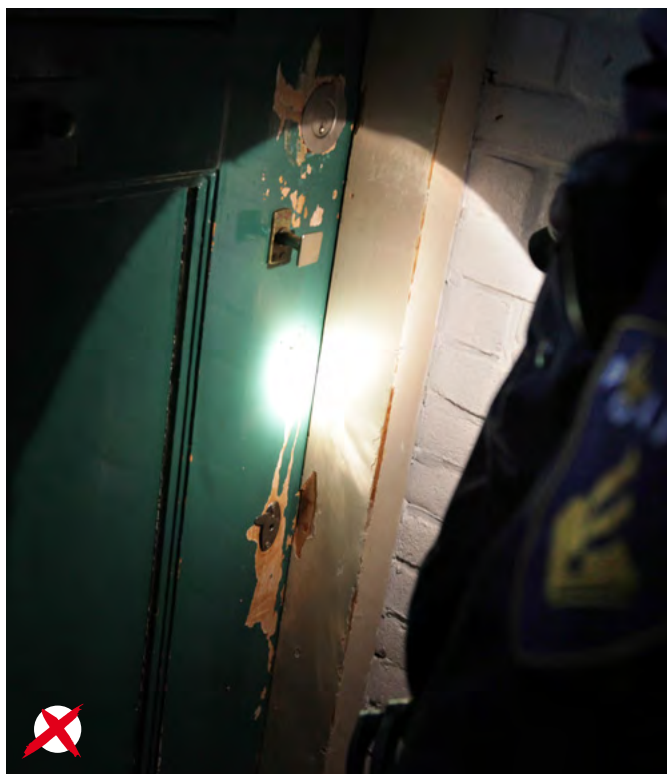
Fout: verlichting ontbreekt hier. De combinatie verlichting, zicht en goed hang- en sluitwerk had een inbraak(poging) in veel gevallen kunnen voorkomen.
