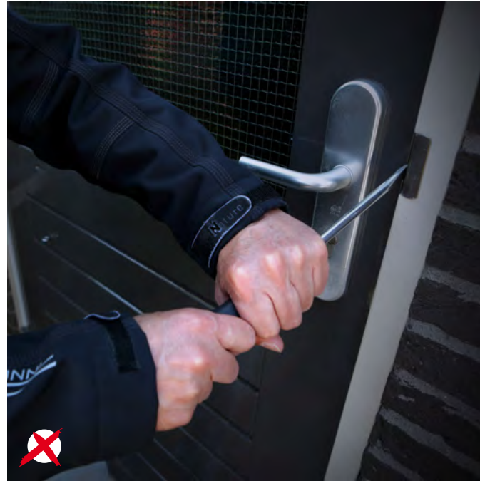
Veel van de inbraken worden met een eenvoudige schroevendraaier gepleegd. Sloten moeten 3 minuten inbraakwerend zijn.
