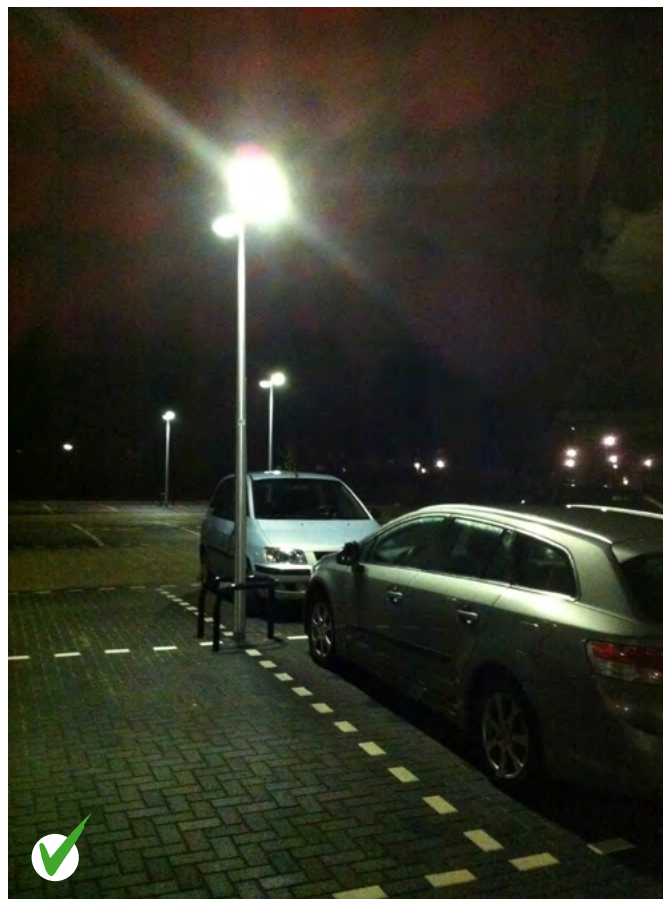
Goed: door de goede kleurweergave van LED-verlichting (tenminste 70 Ra) is dit nu prima toe te passen op parkeerterreinen.
