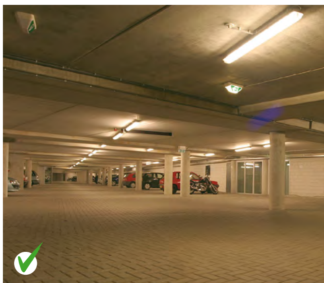
Een garage, gekoppeld aan een woongebouw, moet overzichtelijk en goed verlicht zijn.
