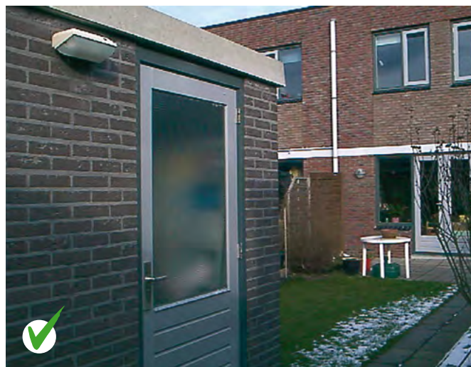
Energiezuinige verlichting op schemerschakelaar.
