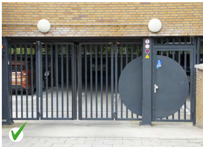
Goed: speedgate versnelt het weer sluiten van een toegang.
